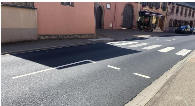
Cette ligne matérialise l'endroit où les usagers circulant sur la chaussée doivent s'arrêter le cas échéant pour assurer une bonne visibilité mutuelle avec les piétons souhaitant traverser. Nous développerons ce dispositif sur l'ensemble de la RD 422 durant l'été pour avoir une sécurité toujours plus importante sur cet axe routier.
