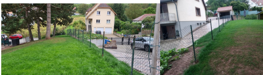
↑ Mise en place d'un nouveau grillage à l'école des Pins. — Photo : Christian FARNER et Michel WILT
