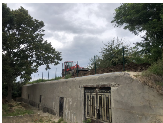
↓ Mise en place de terre au dessus de l'IR6 — Photo : Corentin KINDER
