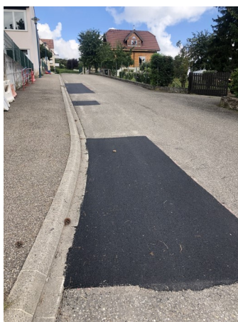
Réfections partielles de la rue de l'école
