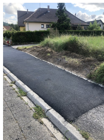
Remise en état du 19 rue du Fort
