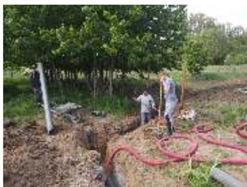
← Mise en place de tuyaux PVC pour permettre de remplir la mare écologique. — Photo : Guy SCHMITT
