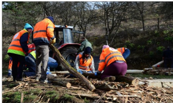
Premières étapes du chantier : l'écorçage et le bûcheronnage des rondins d'acacia.
