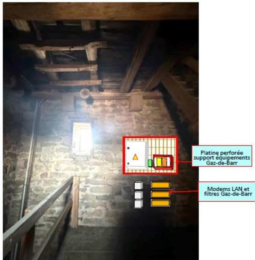
Emplacement du coffret concentrateur Gaz-de-Barr, du boitier plexo 12 modules, du bornier de mise à la Terre sur grille métallique perforée fixée au mur, et les 3 modems LAN et 3 des Filtres sous le coffret concentrateur repris contre le mur au niveau sous le clocher
