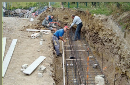
Mur de soutènement
