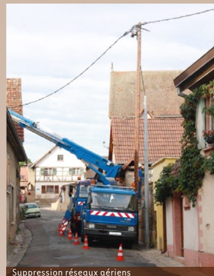
Suppression réseaux aériens
