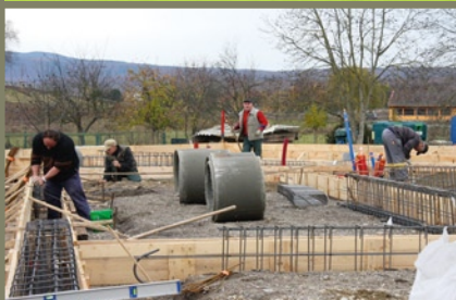
Ateliers municipaux – local pompiers
