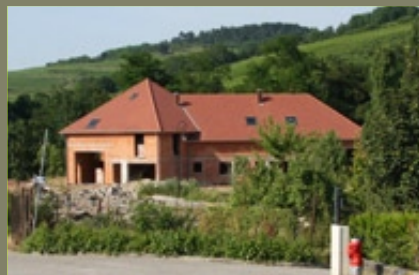
Ateliers municipaux – local pompiers
