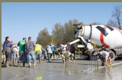
Ateliers municipaux – local pompiers
