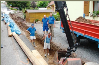
Mur de soutènement
