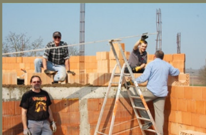
Ateliers municipaux – local pompiers
