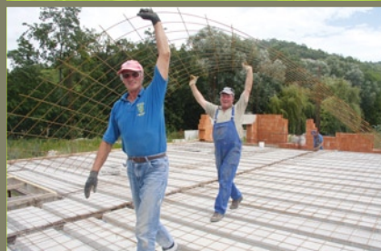
Ateliers municipaux – local pompiers
