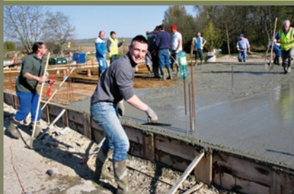
Ateliers municipaux – local pompiers
