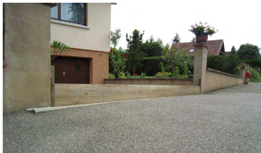
Fig. 24. EXEMPLE D'AMENAGEMENT REALISE PAR UN RIVERAIN DE LA RUE DU FORT
