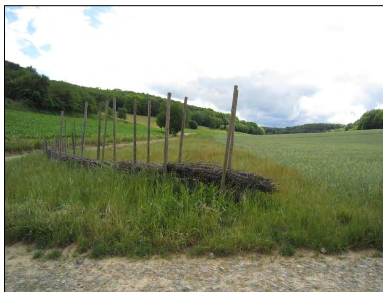
Fig. 18. FASCINES ET BANDE ENHERBÉE À L'AMONT DU FOSSE, LIEU-DIT KAESACKER, SOULTZ-LES-BAINS
