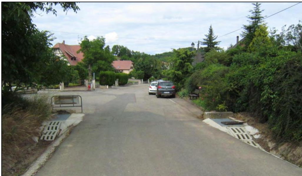
Fig. 9. GRILLE ET DESSABLEUR A L'ENTREE DU RESEAU UNITAIRE, EN AMONT DE LA RUE DU FORT
