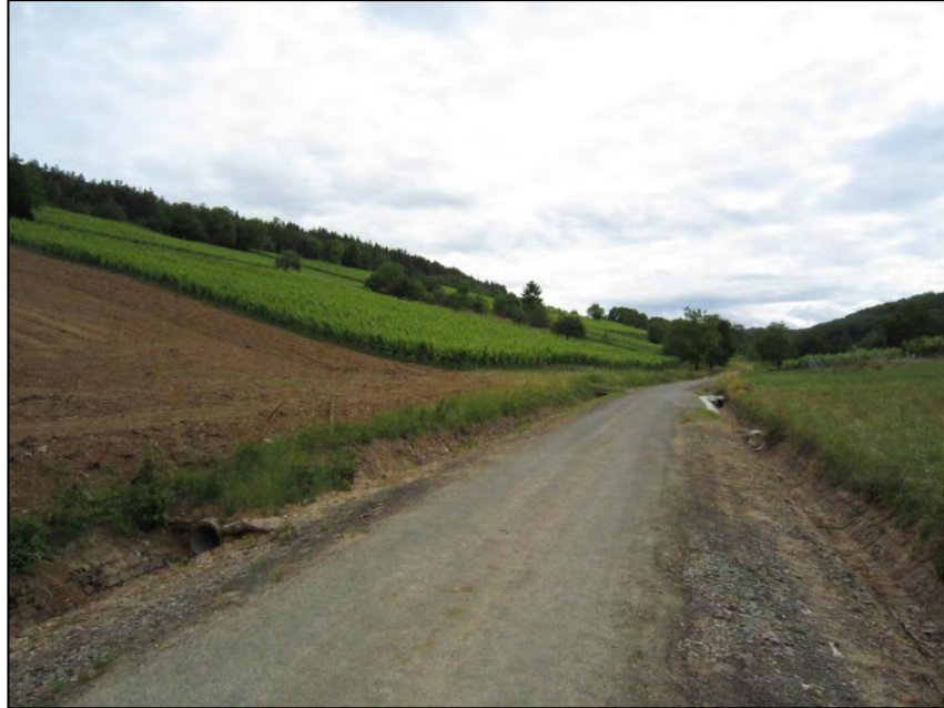
Fig. 8. CHEMIN FORMANT LE THALWEG DANS LA CONTINUITE DE LA RUE DU FORT
